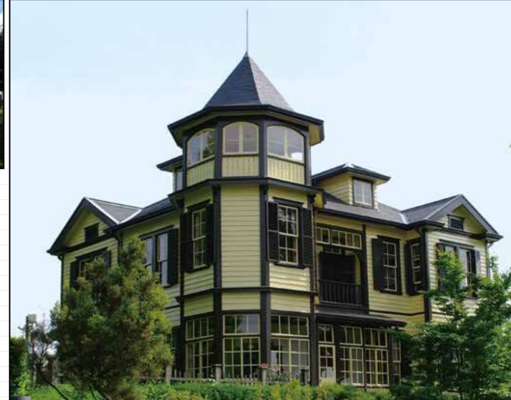
「外交官の家」は修繕工事のため、令和7年3月下旬に再開予定
